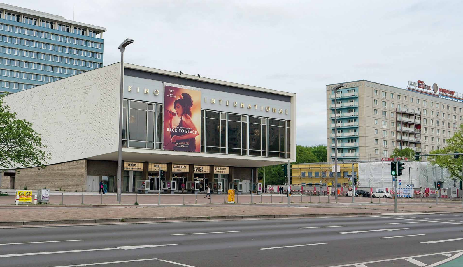
Wohnungsbau im Sozialismus: Mit rationalisierter Planung, typisierten Bauelementen und industrieller Fertigung ließen sich viele Wohnungen zu geringen Kosten und in hoher Qualität schaffen. Foto: Matthias Coers
